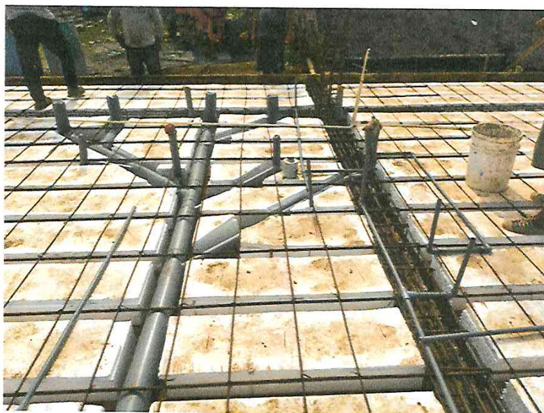
Fotografía N° 10.- Trabajos de instalaciones sanitarias y electricas.
