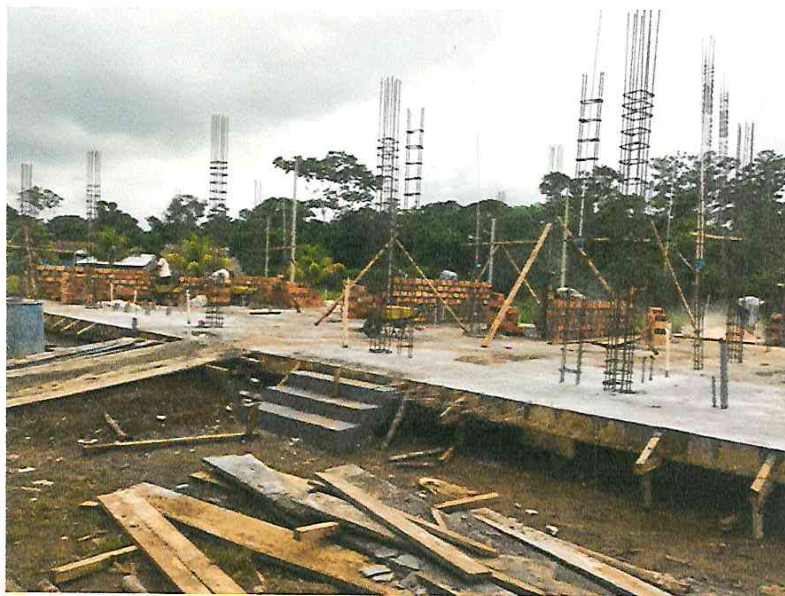
Fotografía N° 13.- Inicio de los trabajos de asentado ladrillo del módulo.
