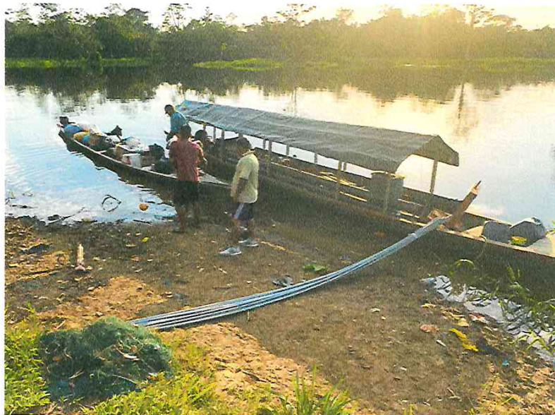
Fotografía N° 07.- En la toma se aprecia el transporte fluvial de los materiales de construcción a la obra.
