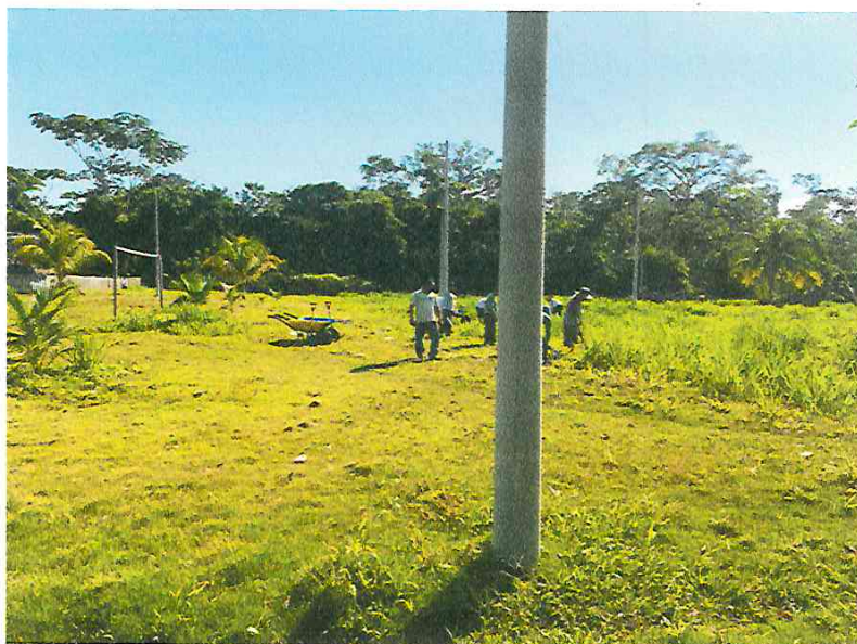
Fotografía N° 01.- En la toma, limpieza de terreno manual.
