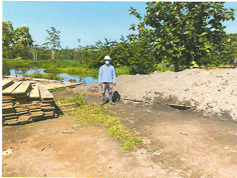
Fotografía N° 03.- Residente de Obra verificando los materiales para encofrado y mortero.
