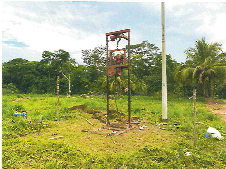
Fotografía N° 16.- Trabajos de perforación de pozo.
