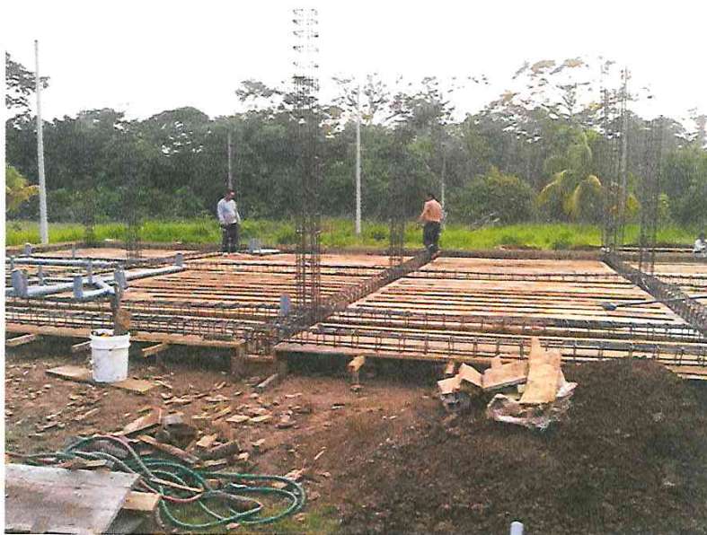
Fotografía N° 09.- En la Vista los trabajos de encofrado de losa aligerada y colocación de acero en vigas principales y secundarias.
