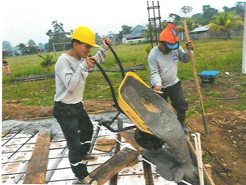
Fotografía N° 12.- Colocación de mortero en vigas principales de la losa aligerada.
