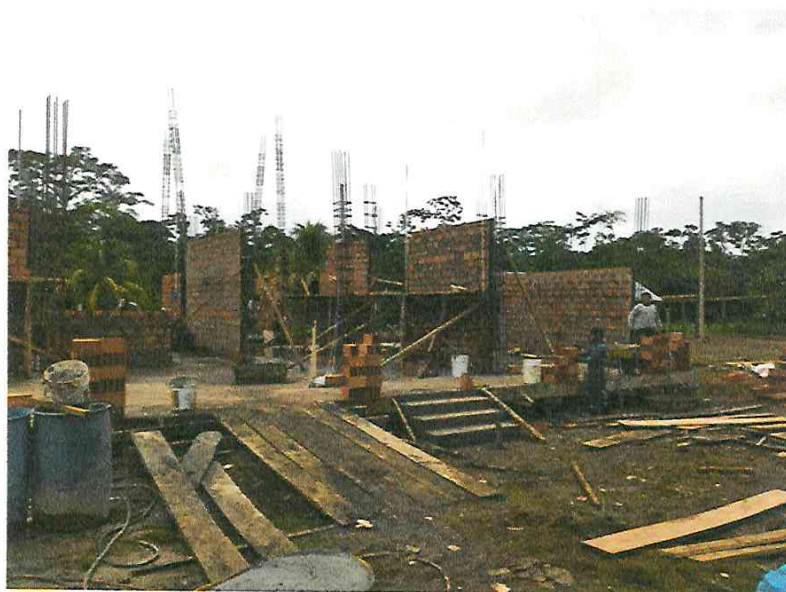
Fotografía N° 13.- Inicio de los trabajos de asentado ladrillo del módulo.
