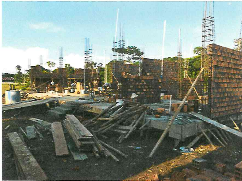
Fotografía N° 15.- Vista panorámica de los trabajos de asentado de ladrillo en todos los frentes del módulo.
