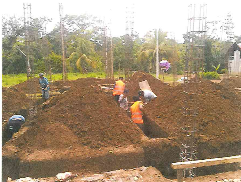
Fotografía N° 08.- Trabajos de excavación de zanjas para vigas de cimentación.
