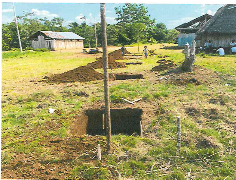
Fotografía N° 06.- Vista de los trabajos de excavación de zanja para las zapatas.
