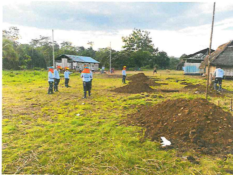
Fotografía N° 04.- Vista de los trabajos de excavación de zanjas para zapatas.
