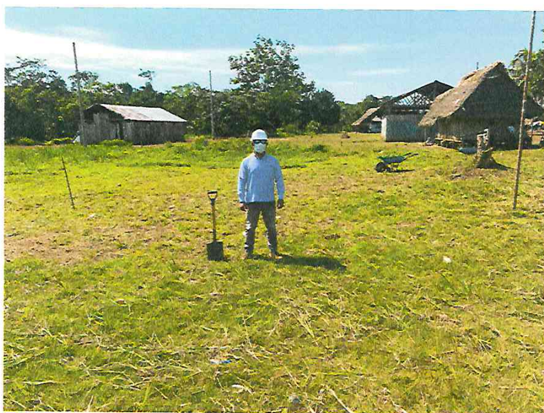
Fotografía N° 02.- Residente de Obra verificando el insito los trabajos de trazo, niveles y replanteo.
